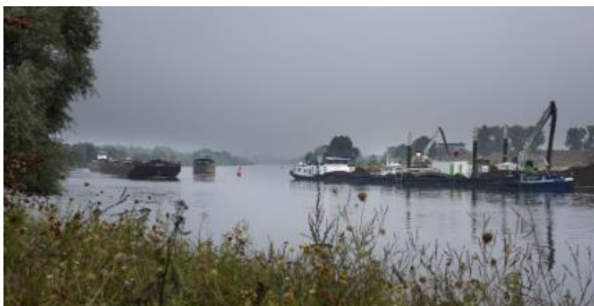
Figuur 1: Werkzaamheden bij bocht Steijl
